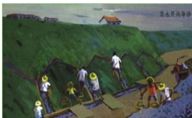
图 5-4 开沟导渗方法示意图
