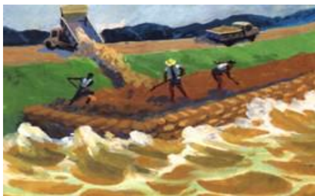
图 5-3 抛填粘土前戗方法示意图
