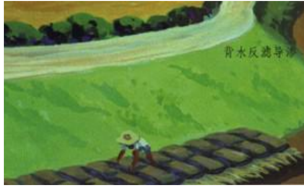
图 5-5 反渗导漏方法示意图
