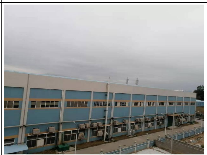
图片 4 项目西侧广东先导稀材股份有限公司
