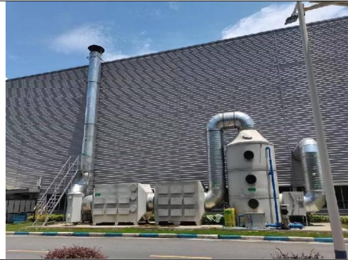
项目一期工程现状图
