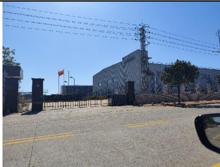
东侧——飞机起落架维修公司
