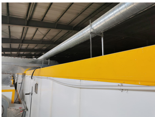
烘干炉-配设设备直连管道抽风收集
