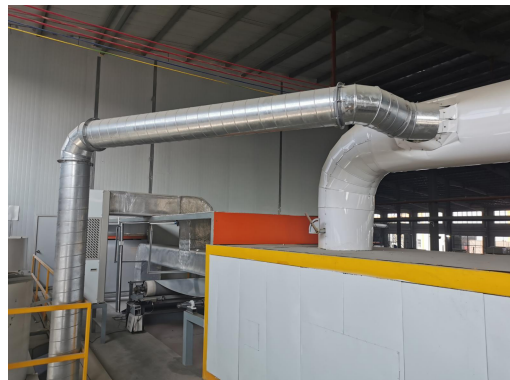
烘干炉出口-配设设备直连管道抽风收集
