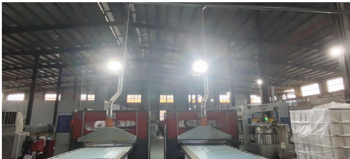
淋胶线集气罩-涂胶段进、出口处均设置上吸式集气罩（带围挡）
