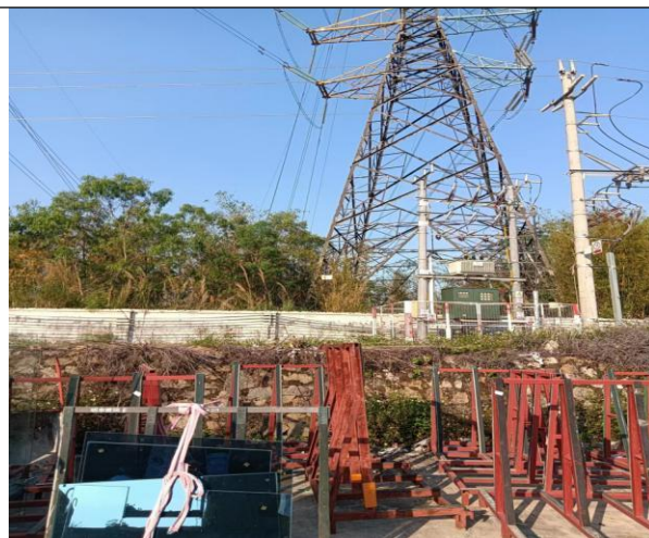
2#车间北面（林地）
