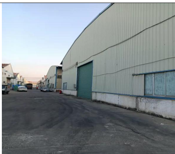
1#车间西面（空置厂房）
