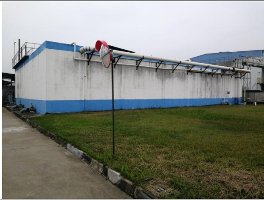
现有项目污水处理站
