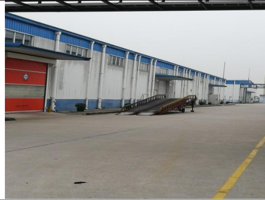
项目南面厂房
