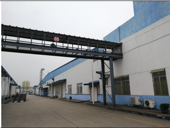
项目西面厂房
