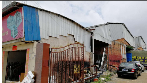
项目西面--安达钢管扣件租售部
