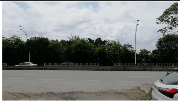
项目南面--清四公路
