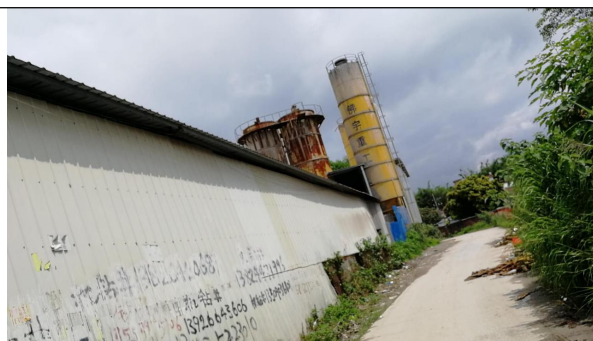
项目现状--水泥罐
