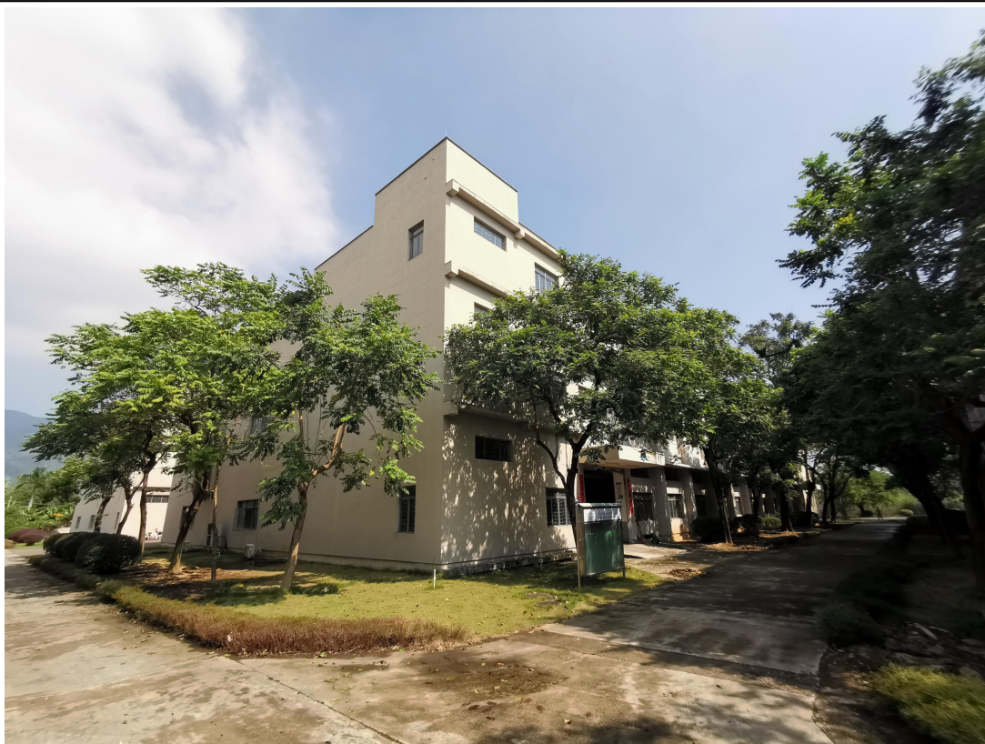
图片 4 项目北面（清远邦泰复合材料有限公司厂房二）
