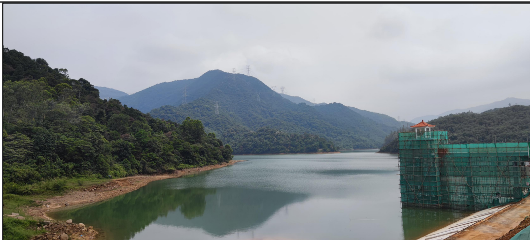
图 3-1 大秦水库饮用水源保护区现场照片
