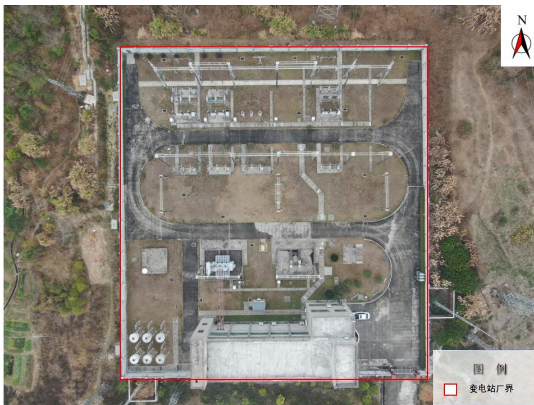
图 9 110kV 南龙变电站四至图
