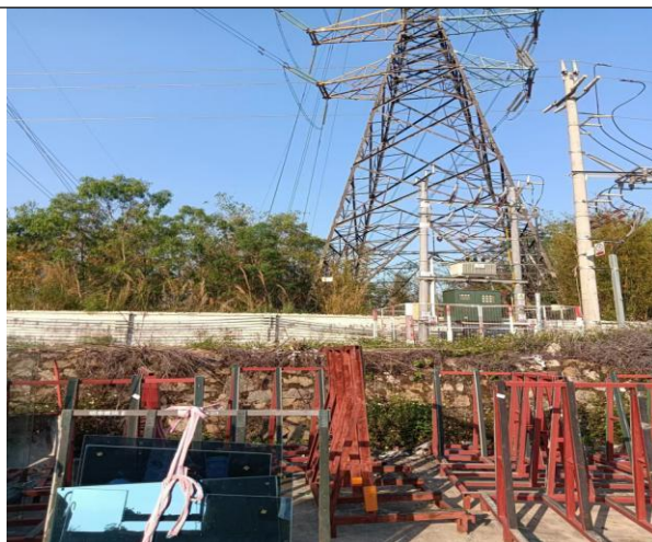
2#车间北面（林地）
