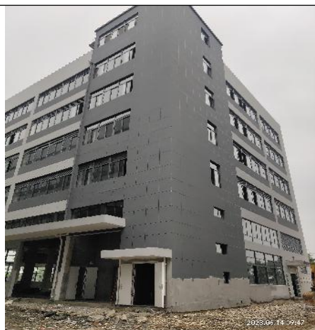
项目西面（空厂房）
