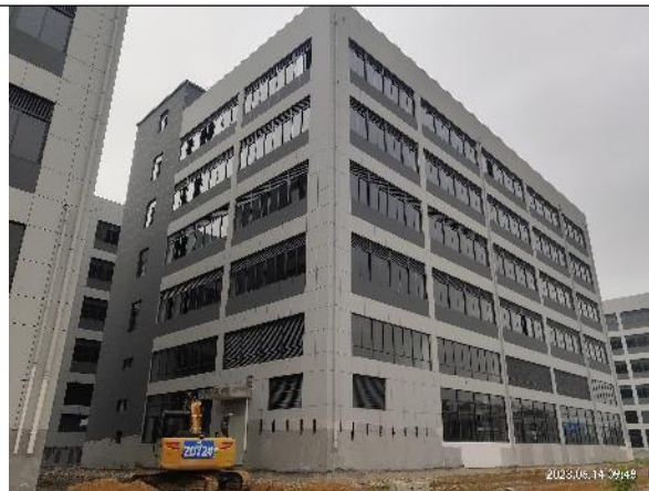
项目南面（空厂房）
