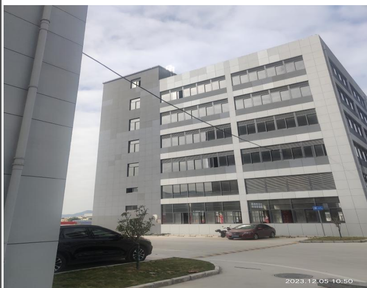
图片 4 项目西侧（园区 5#号厂房）
