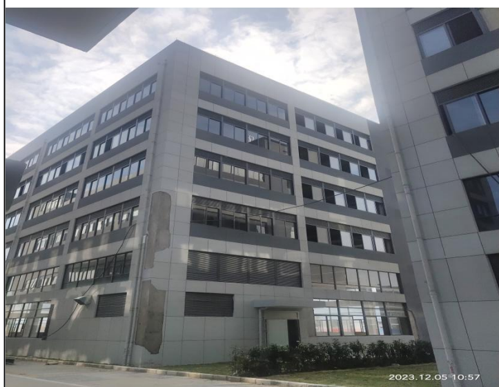
图片 2 项目东侧（园区 7#号厂房）
