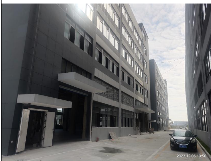
图片 5 项目北侧（园区 2#号厂房）
