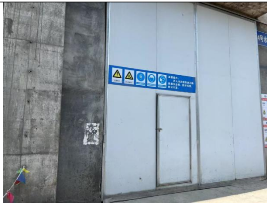
水泥包装机主袋除尘器
