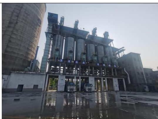
水泥散装除尘措施
