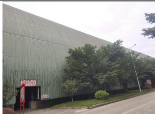
原煤均化堆场密闭
