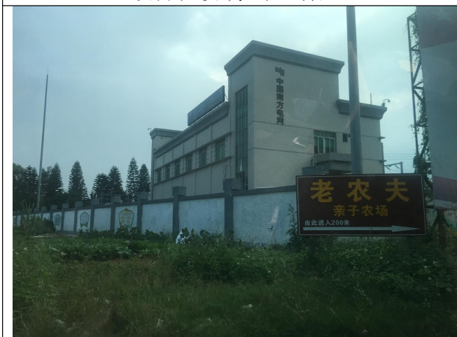
项目东南面--南方电网变电站
