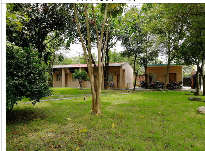
项目现状-办公生活区
