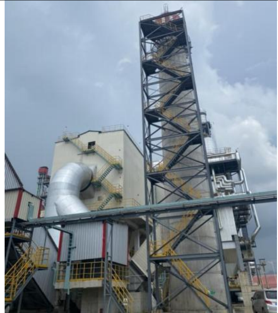
C 线窑头布袋除尘器
