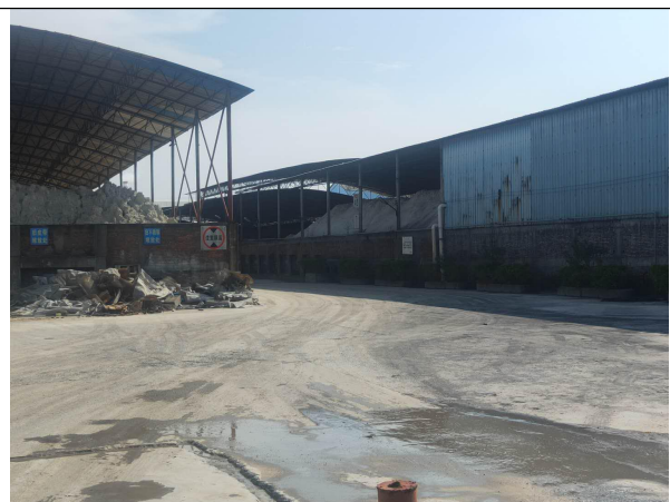
项目北面（天域原料仓）
