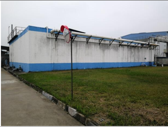
现有项目污水处理站
