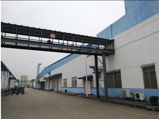
项目西面厂房
