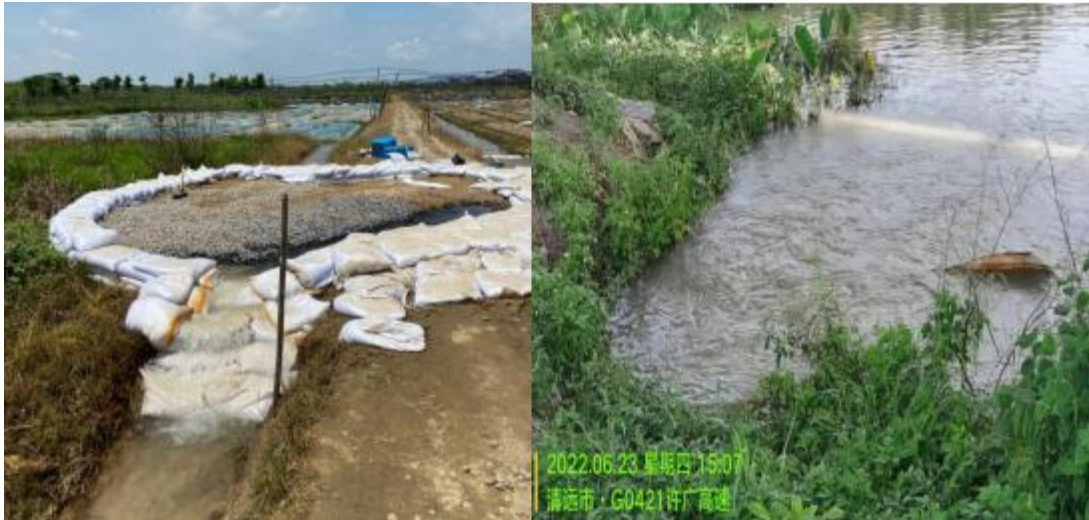
图 2.3-1 清西联围清西围段胜利村附近两处管涌
