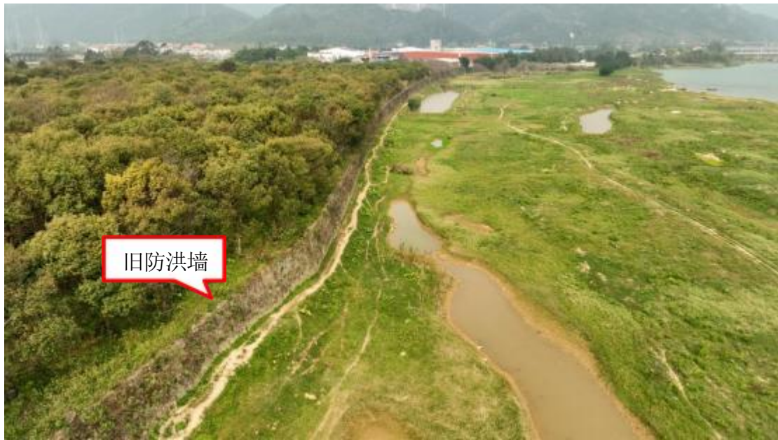
图 5.4-13 黄岗联围拟新建堤防现场照片
