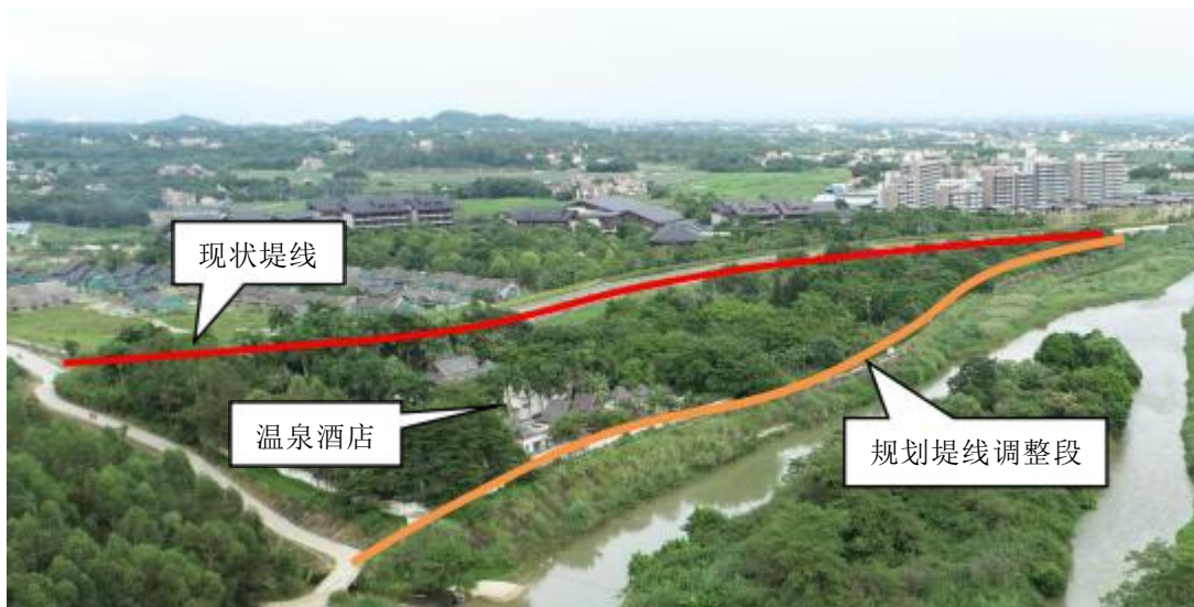
图 5.4-23 清西围漫水河支堤现场照片
