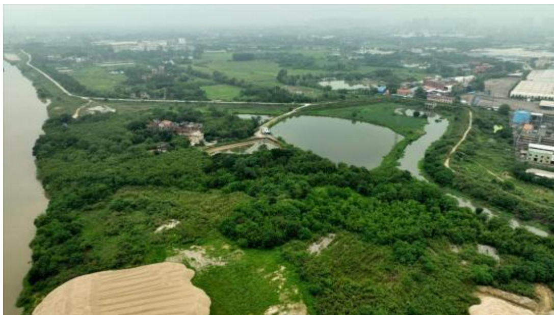
图 5.4-21 正江左岸飞水围调整堤线段现场照片
