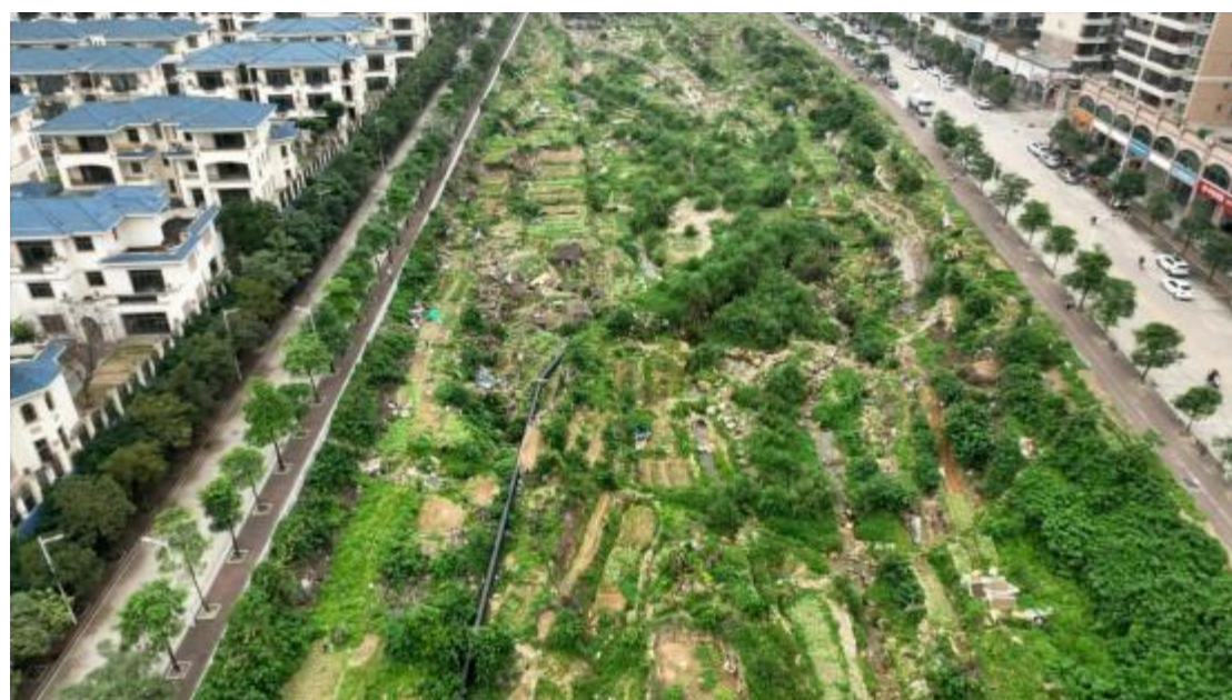
图 5.4-26 大和坑现场照片
